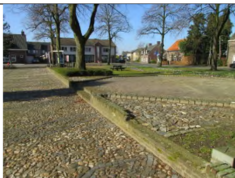
Foto 13: Delen van de rollaag ontbreekt KM01.
