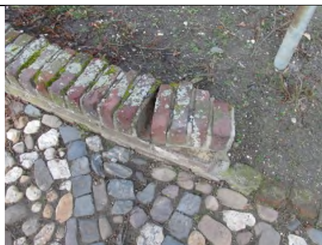
Foto 14: Delen van de rollaag liggen los KM01.
